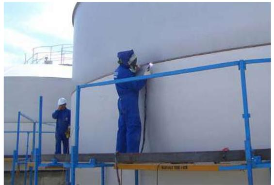
Trabajo en exteriores de soldeo de tanques de acero inoxidable – una aplicación típica de los hilos tubulares rellenos de fundente para soldeo en todas posiciones de Böhler Welding. El metal base de los tanques es UNS S32101 y se suelda con Avesta FCW LDX 2101-PW (E2307T1-4/1).
